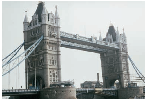
Εικόνα 31.6: Η γέφυρα του Πύργου του Λονδίνου
