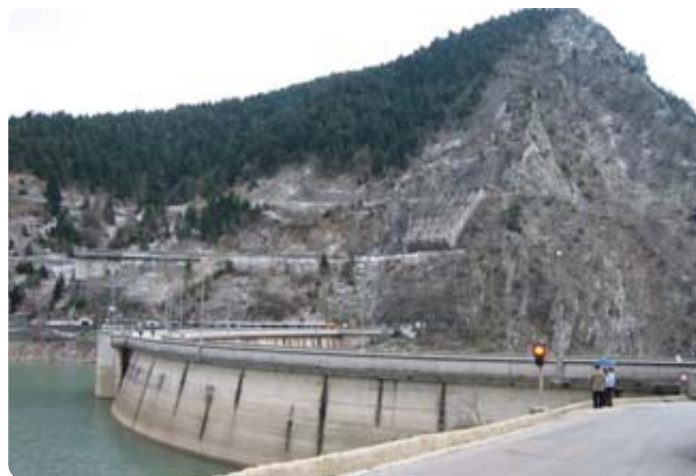
Φράγμα Ταυρωπού (Ν. Καρδίτσας).
