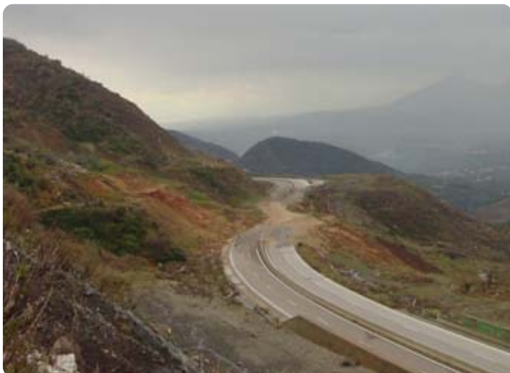
Κατολίσθηση στην Τσακώνα (Εθνική οδός Μεγαλόπολης-Καλαμάτας).
