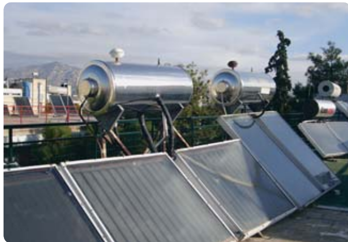
Ηλιακοί θερμοσίφωνες σε ταράτσα πολυκατοικίας.
