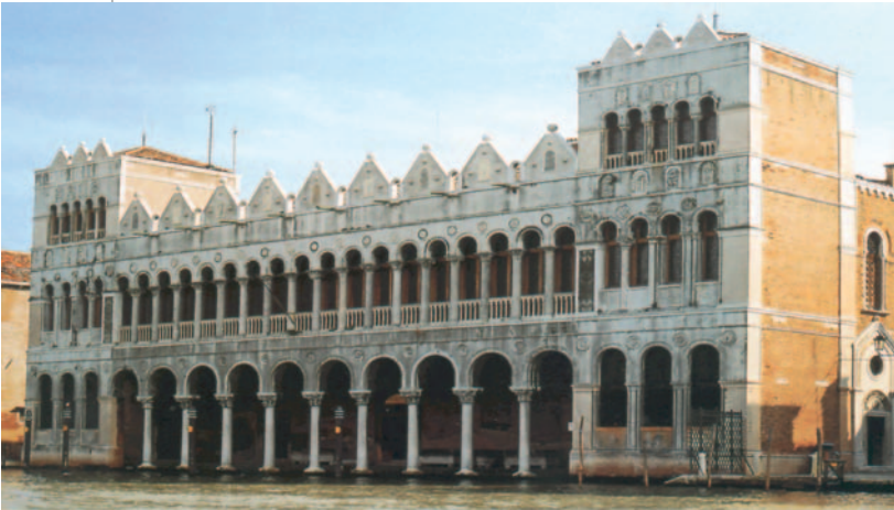
25. Το κτίριο «Φοντάκο Ντέι Τούρκι» στη Βενετία, 13ος αι.
