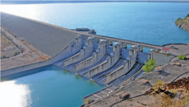
Το φράγμα και η τεχνητή λίμνη Στράτου
