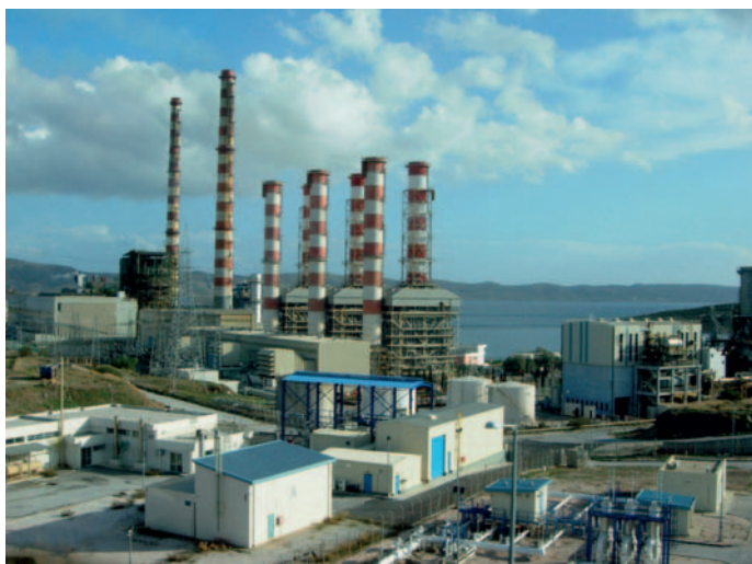
42.7 Λαύριο: θερμοηλεκτρικός σταθμός Δ.Ε.Η.
