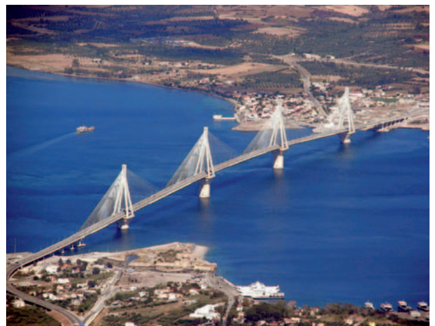
43.3 Γέφυρα «Χαρίλαος Τρικούπης», ένα μεγάλο ευρωπαϊκό τεχνικό έργο στην Ελλάδα
