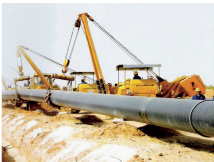
42.10 Κατασκευή αγωγού φυσικού αερίου
