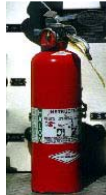
Σχήμα 2.53 Σήμα πυρκαγιάς κατηγορίας B και πυροσβεστήρας
