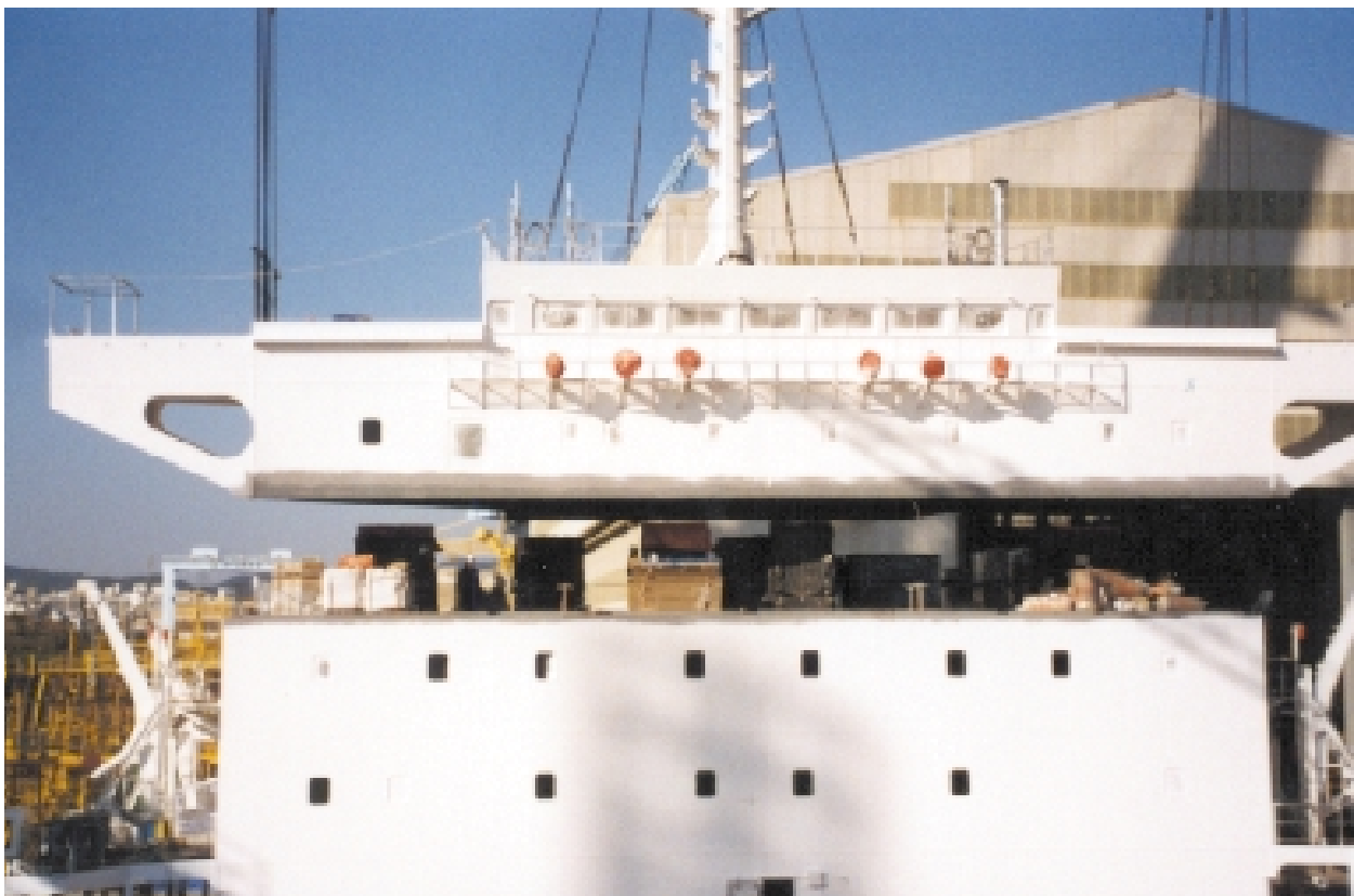
Φωτ. 9.6 Τοποθέτηση γέφυρας
