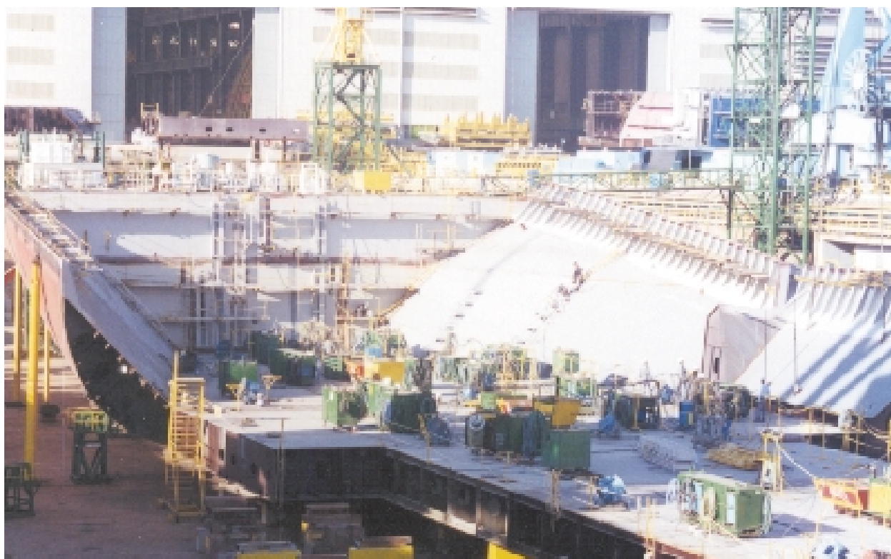
Φωτ. 9.2 Αρχικά στάδια κατασκευής - Διπύθμενα πλοίου
