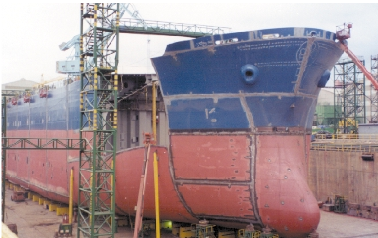
Φωτ. 9.5 Τοποθέτηση προραίου block
