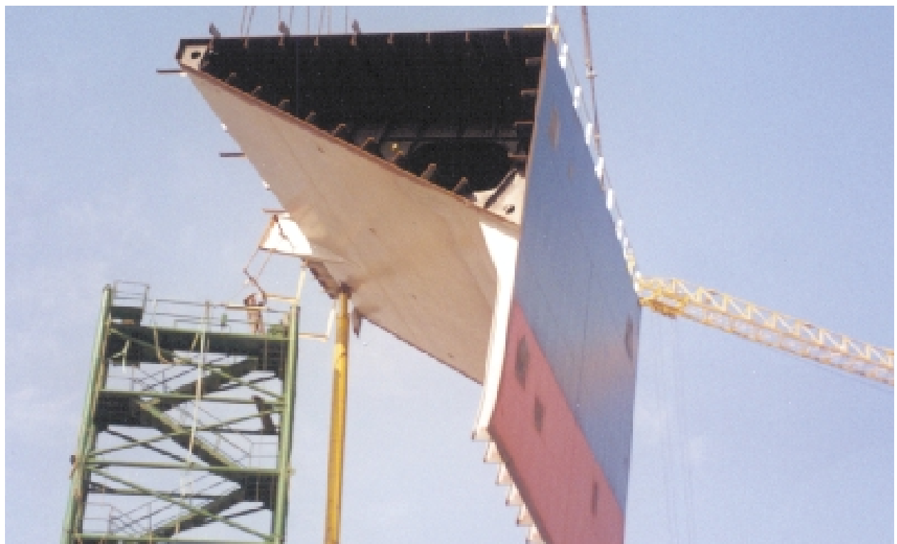
Φωτ. 9.4 Τοποθέτηση πλευρικού block και άνω πλευρικής δεξαμενής έρματος
