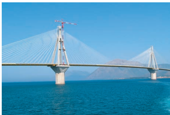
Η μεγάλη σύγχρονη γέφυρα στο Ρίο-Αντίρριο (εικ. 1).
