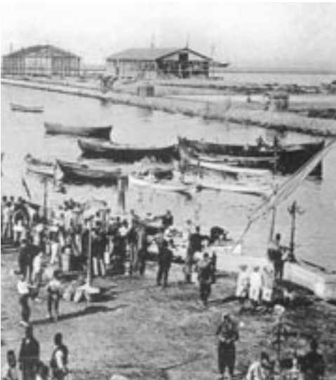
Λιμάνι: Έργα επέκτασης
