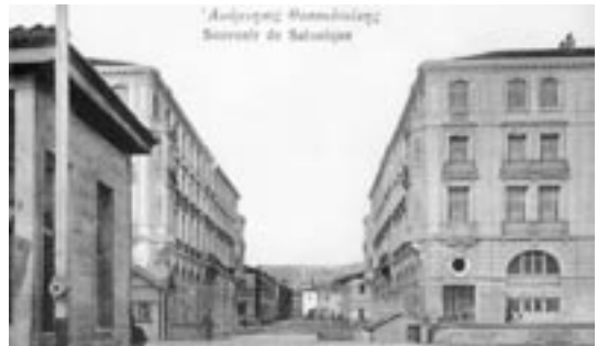
Κτίρια γραφείων της Γαλλικής Εταιρείας Κατασκευής και Εκμετάλλευσης Λιμένος. Βρίσκονταν στην οδό Σαλαμίνος
