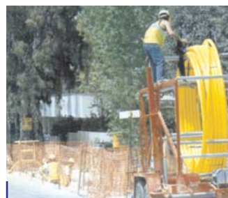
Τοποθέτηση αγωγού φυσικού αερίου
