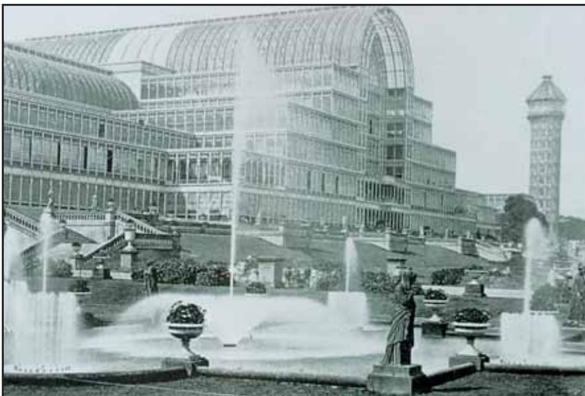
Το «Κρίσταλ Πάλας» (Crystal Palace) στο Χάιντ Παρκ του Λονδίνου σχεδιάστηκε και κατασκευάστηκε μέσα σε έξι μήνες από τον Τζόζεφ Πάξτον (Joseph Paxton), το 1851, για την πρώτη παγκόσμια έκθεση. Ήταν η μεγαλύτερη κατασκευή της εποχής, για την οποία χρησιμοποιήθηκαν αποκλειστικά προκατασκευασμένα μεταλλικά στοιχεία και γυαλί. Μετά τη λήξη της έκθεσης τα μέρη που την αποτελούσαν αποσυνδέθηκαν και η κατασκευή μεταφέρθηκε και τοποθετήθηκε στο νότιο Λονδίνο, όπου και καταστράφηκε από πυρκαγιά το 1937.
