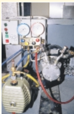
Σχήμα 2: Σύνδεση του οργάνου για τη δημιουργία κενού.
