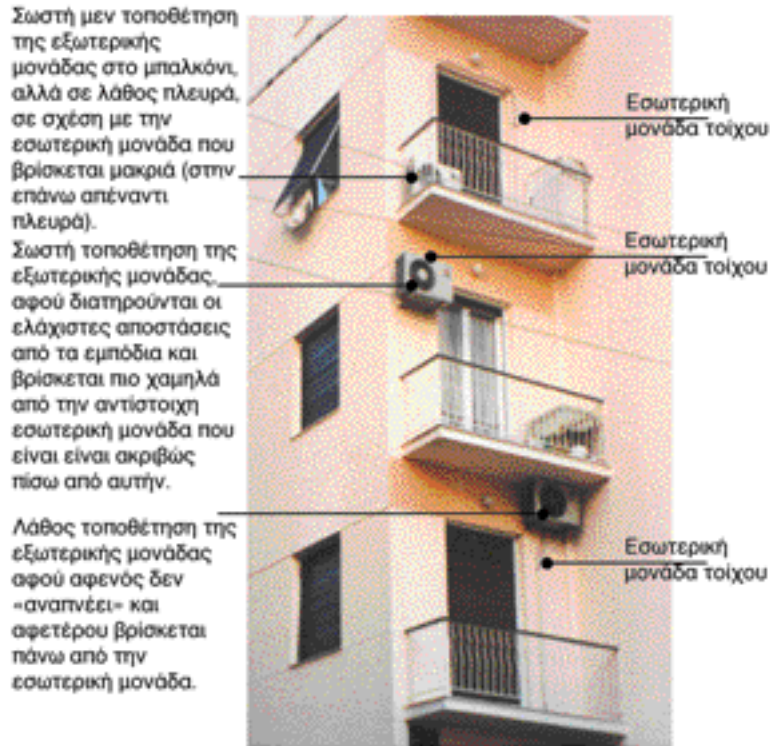
Εικόνα 3.10: Εξωτερικές μονάδες κλιματιστικών, διαιρούμενου τύπου, για μικρούς χώρους μιας κατοικίας με διάφορους τρόπους εγκατάστασής τους (ορθούς-λανθασμένους).
