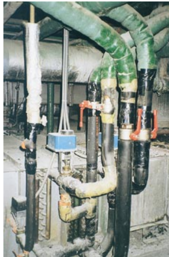
Εικόνα 3.23: Σύνδεση σωληνώσεων προσαγωγής και επιστροφής προς το θερμαντικό και ψυκτικό στοιχείο του ζεστού και κρύου νερού της ΚΚΜ. (Μια τρίοδη ηλεκτροβάννα ρυθμίζει την παροχή προς κάθε ένα στοιχείο, σύμφωνα με τις απαιτήσεις. Οι σωλήνες είναι εξωτερικά θερμομονωμένοι για τη μείωση των απωλειών θερμότητας. Η θερμομόνωση έχει εξωτερική προστατευτική άσπρη βαφή (επάνω αριστερά) ή αλουμινένιο κάλυμμα, για ακόμη μεγαλύτερη προστασία (επάνω δεξιά). Αν δεν ληφθούν προστατευτικά μέτρα, με την πάροδο του χρόνου, η θερμομόνωση καταστρέφεται (κάτω), όμως, για την αποκατάστασή της πρέπει να αποφεύγεται η χρήση μονωτικής ταινίας).
