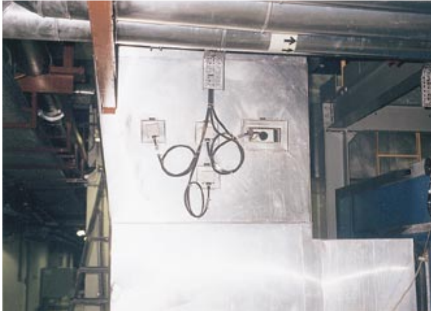
Εικόνα 3.27: Αισθητήρες θερμοκρασίας και υγρασίας, προσαρμοσμένοι πάνω στον κύριο αγωγό στη ΚΚΜ, για να καταγράφει και να παρέχει δεδομένα στο σύστημα ελέγχου.
