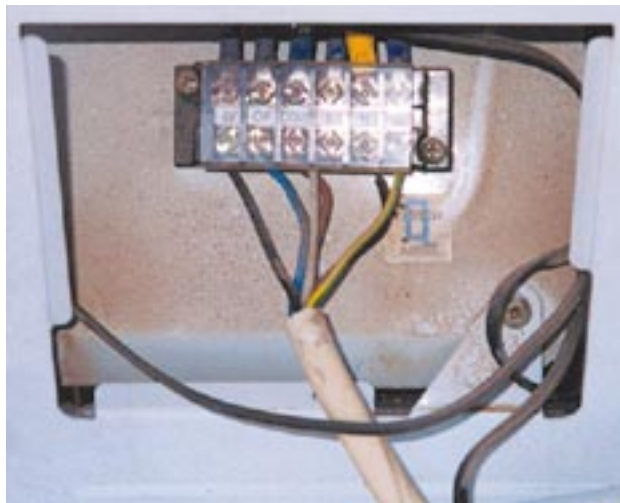
Εικόνα 3.15: Ηλεκτρικό κύκλωμα εξωτερικής μονάδας (επάνω) και λεπτομέρεια σύνδεσης με το καλώδιο που έρχεται από την εσωτερική μονάδα (κάτω).
