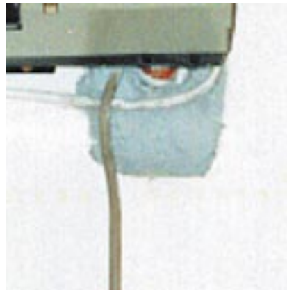
Εικόνα 3.18: Σφράγισμα της τρύπας, απ' όπου περνούν οι σωλήνες του ψυκτικού, με ελαφροτσιμέντο. (Το άσπρο καλώδιο είναι για την ηλεκτροδότηση της μονάδας, ενώ το σκουρόχρωμο είναι του ενσύρματου τηλεχειριστηρίου).
