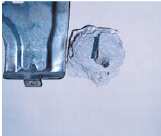
Εικόνα 3.13: Αποτυχημένη επιλογή θέσης για το άνοιγμα οπής, στο ύψος του δοκαριού. (Διακρίνεται το σίδερο του οπλισμού στο μπετόν).
