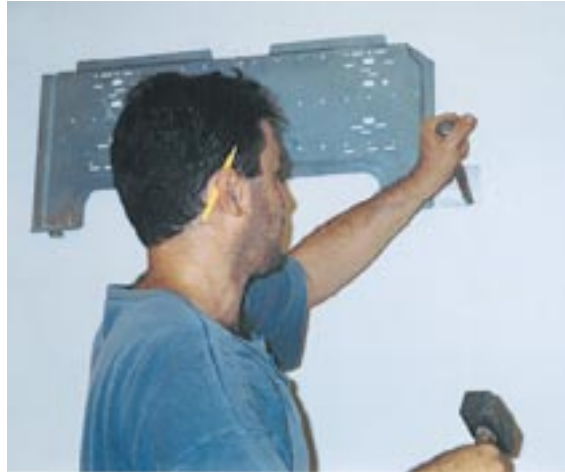
Εικόνα 3.12: Τοποθέτηση της μεταλλικής βάσης για το «κρέμασμα» της εσωτερικής μονάδας στον τοίχο και άνοιγμα της τρύπας για τη σύνδεση της με την εξωτερική μονάδα.
