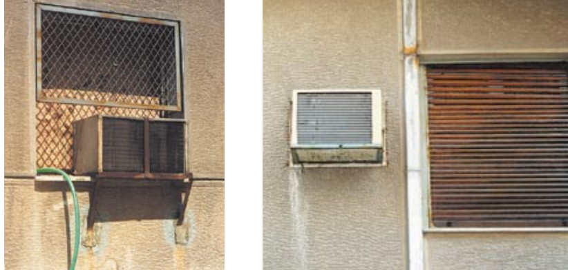
Εικόνα 3.5: Ενιαίου τύπου κλιματιστική μονάδα, τοποθετημένη σε παράθυρο (αριστερά) και τοίχο (δεξιά).
