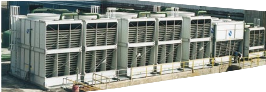
Σχήμα 8-73: Συγκρότημα πύργων ψύξης εγκατάστασης βιομηχανικού κλιματισμού
