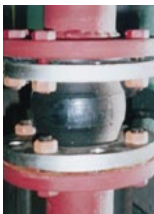
Σχήμα 6-35: Αντικραδασμικός σύνδεσμος από καουτσούκ, συνδεδεμένος σε δίκτυο
