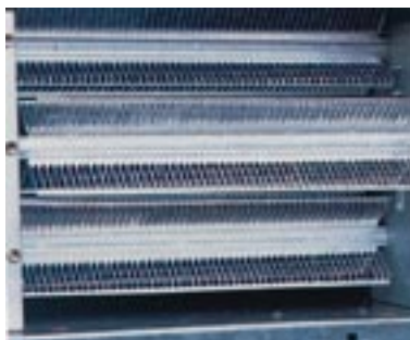
Σχήμα 8-51: Στοιχείο με ηλεκτρικές αντιστάσεις
