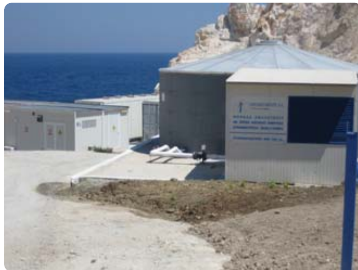
Μονάδα αφαλάτωσης στη Μήλο.
