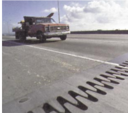
Εικ. 1.6 Γέφυρα με πρόβλεψη της διαστολής και συστολής της λόγω μεταβολής της θερμοκρασίας.
