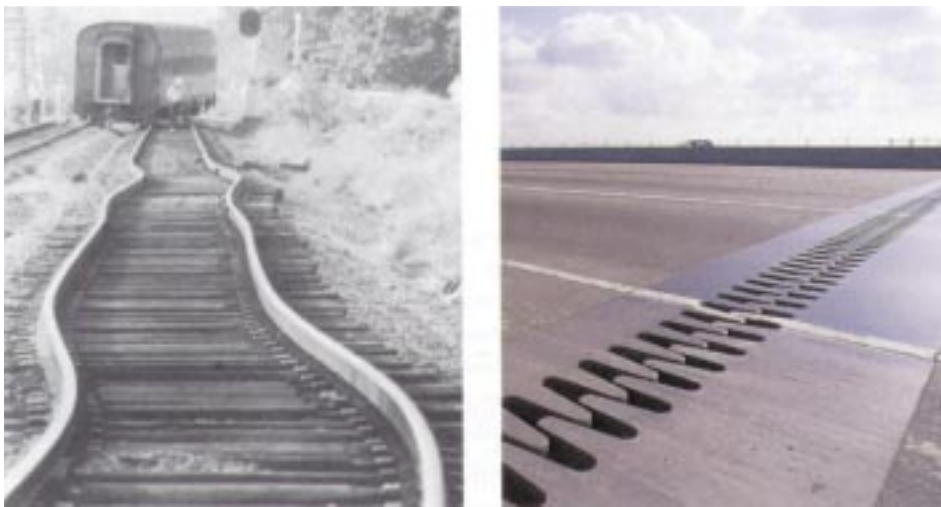
Εικ. 1.22 (α) Οι σιδηροτροχιές παραμορφώθηκαν, γιατί δεν ελήφθη πρόνοια για τη θερμική διαστολή. (β) Σε μια μεγάλη γέφυρα συναντάμε αυτές τις σχάρες μεταξύ τμημάτων, για να είναι δυνατή η ανεμπόδιση διαστολή της.
