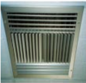
Ορθογωνικό στόμιο οροφής, με ρυθμιζόμενα πτερύγια
