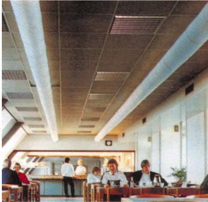
Εικόνα 5.8: Εγκατεστημένοι υφασμάτινοι αεραγωγοί για τον κλιματισμό μιας αίθουσας εστιατορίου.
