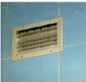
Ορθογωνικό στόμιο τοίχου, με ρυθμιζόμενα πτερύγια.
