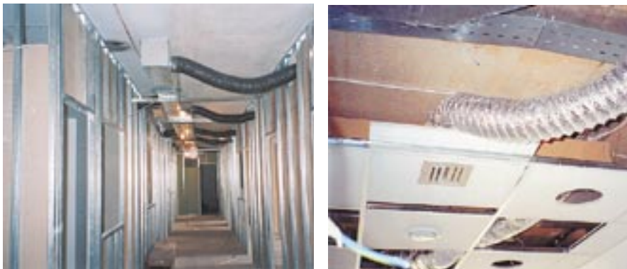
Εικόνα 5.6: Κεντρικός αεραγωγός εξαερισμού κατά μήκος (στο άνω αριστερό μέρος) ενός διαδρόμου σε χώρο γραφείων. Ο αεραγωγός συνδέεται με εύκαμπτους αεραγωγούς (δεξιά) που καταλήγουν σε στόμια εξαερισμού μέσα στα γραφεία.
