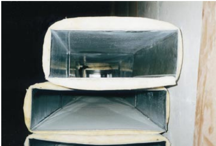
Εικόνα 5.5: Τμήματα θερμομονωμένων αεραγωγών (ορθογώνιας διατομής), πριν τη συναρμολόγησή τους.
