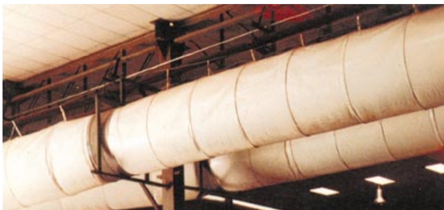
Εικόνα 5.7: Υφασμάτινοι αεραγωγοί.
