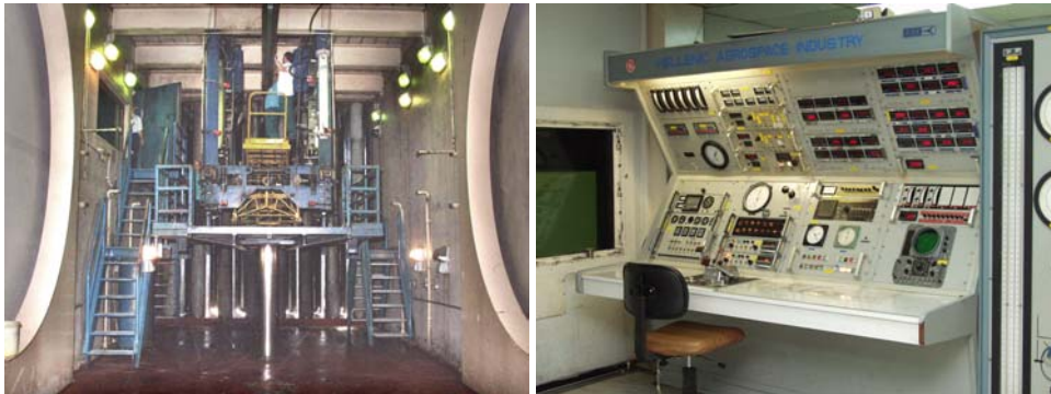
Σχήμα 2.30 Δοκιμαστήριο εμβολοφόρων κινητήρων και αίθουσα ελέγχου
