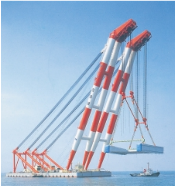
Εικόνα 3.42 (α): Πλωτός γερανός για ανύψωση πολύ μεγάλων βαρών. Όπως φαίνεται, το βάρος ισομοιράζεται σε τέσσερις ομάδες συρμάτων, η καθεμία από τις οποίες έχει ανυψωτική δύναμη 875 τόνων ( 875 \times 4 = 3500 τόνοι). Αυτός ο τύπος του γερανού έχει τη δυνατότητα να σηκώνει ή να κατεβάζει τη «μπούμα», χωρίς να τη μετακινεί αριστερά ή δεξιά ή να την περιστρέφει.
